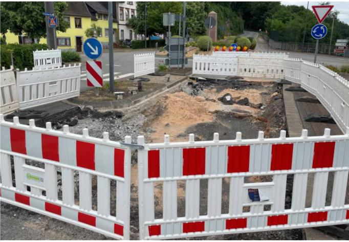
*Langzeitbaustelle: Der schadhafte Durchlauf der Wadrill unter der Brücke des Kreisels in der Birkenfelder Straße soll nun im Frühjahr 2024 saniert werden. Laut LfS laufen aktuell die entsprechenden Genehmigungsverfahren.*
