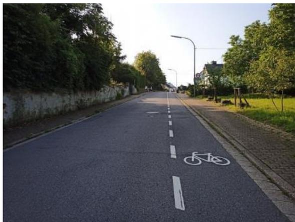
**Abb. 20 Prinzipskizze eines alternierenden Schutzstreifens**
