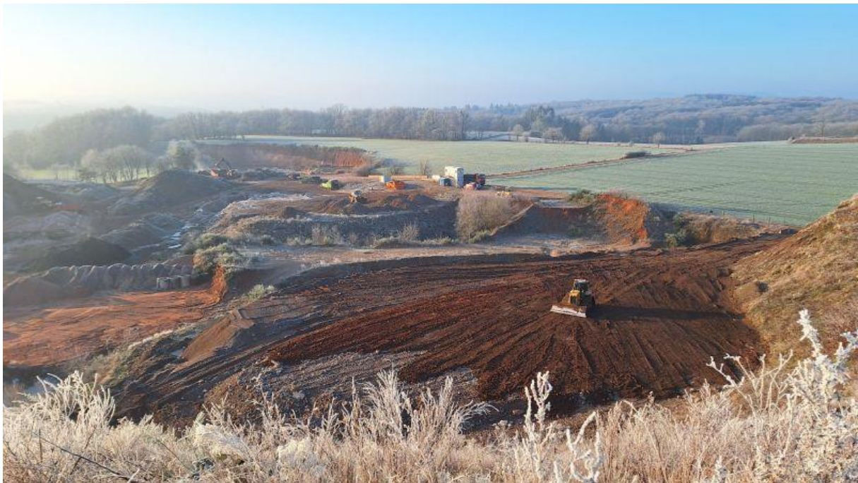
Blick von Südost nach Nordwest über die Fläche des geplanten Vorhabens im Januar 2025 - © Jessica Seibel
